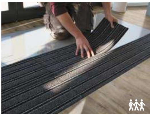
Tapis d'entrée modulaire pouvant être incrustée dans les sols LVT sans détérioration du support et sans décaissage préalable. Le Quick Mat est un tapis d'entrée qui se présente sous forme de lames, chacune composée de 2 bandes de moquette polyamide très absorbantes, et bordées par de fines bandes en polypropylène qui facilitent le grattage du dessous des semelles pour une hygiène impeccable.
